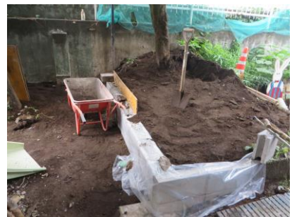
裏庭のフェンスも土台から工事中です
