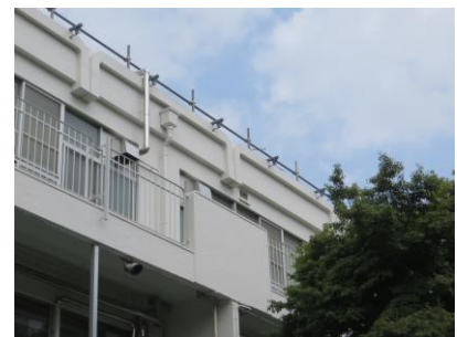
猛暑の中、屋上の防水工事が進みました
