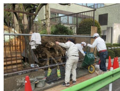
フェンス改修は基礎からの工事でした
