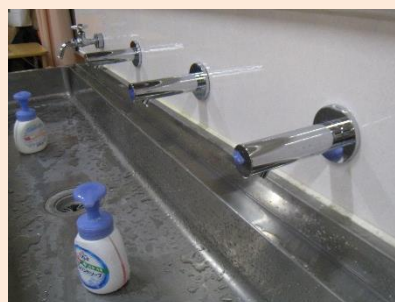
手を触れずに水が出る自動水栓に交換
